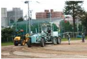
重機を使用した作業
