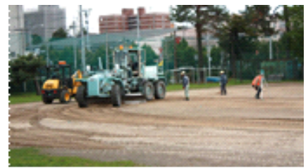
グラウンド整備(花本建設)7/上旬予定
